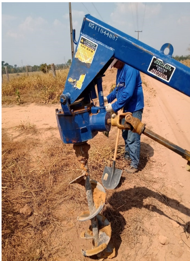
– Sondagem e Coleta de Amostra
