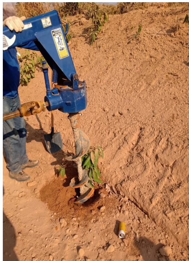
– Sondagem e Coleta de Amostra
